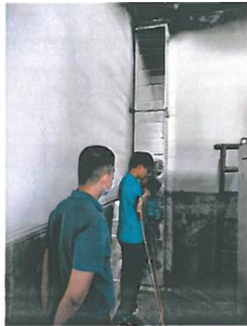
备用发电机废气排放口 2
