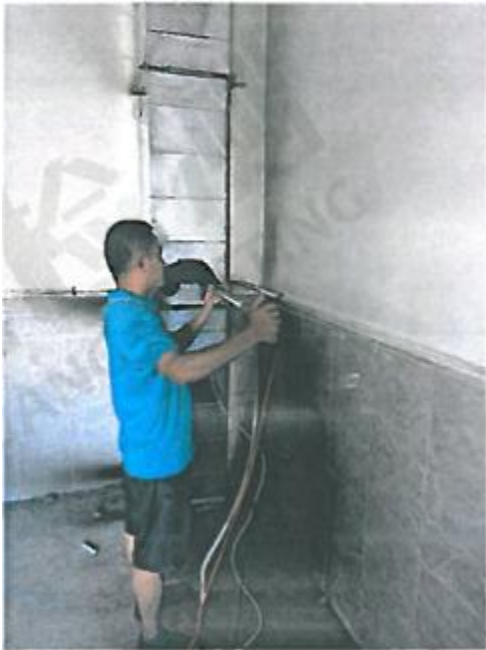
备用发电机废气排放口 1
