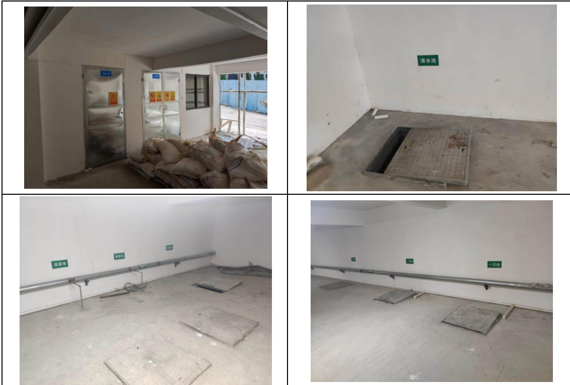
污水处理站池体
