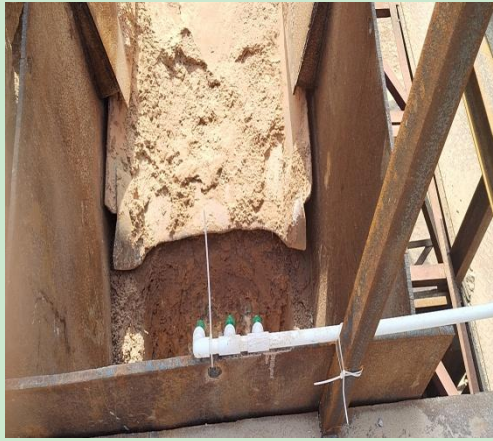
生产线喷淋装置
