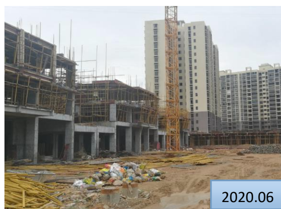
场二期工程西侧场地施工
