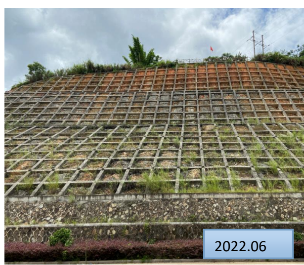
边坡防护区绿化
