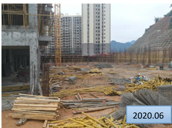
二期工程中中部场地施工
