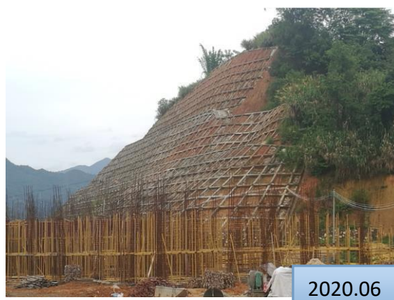
挖方边坡混凝土格梁防护
