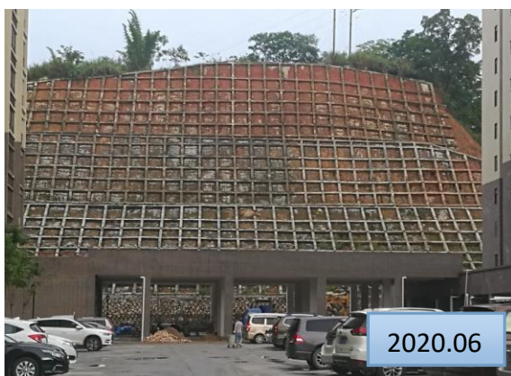
挖方边坡混凝土格梁防护
