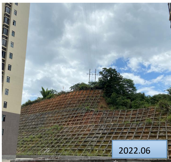
边坡防护区绿化
