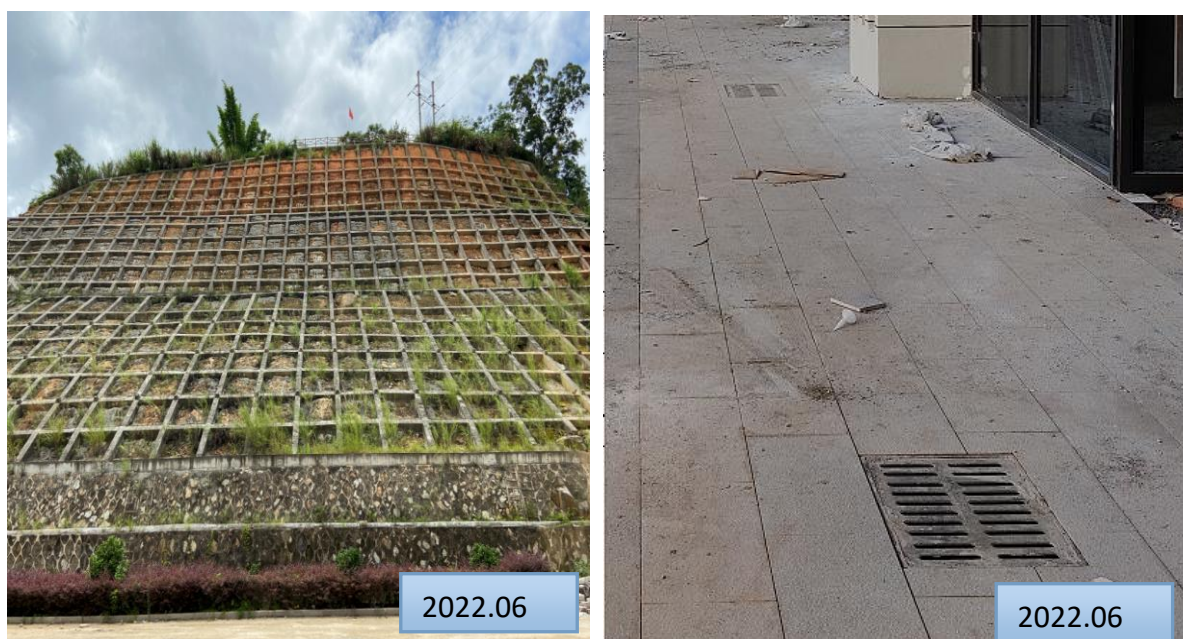
混凝土骨架格梁
